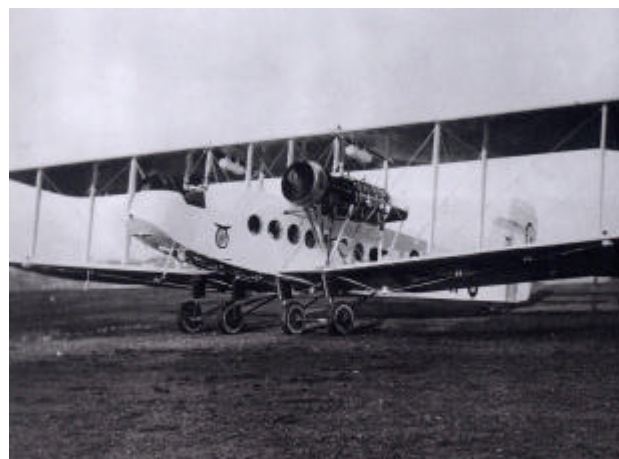
1919: avión comercial Pullman, con 14 asientos, desarrollado por Handlet Page, en un intento de competir con el transporte de viajeros por barco y tren.
